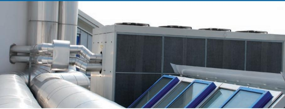
*Eine klassische, mit Strom getriebene Kältemaschine*
