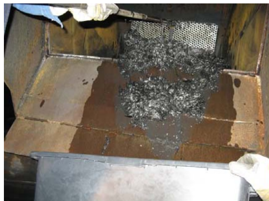
Abbildung 9-5: Materialaustrag am Nassentschlacker
