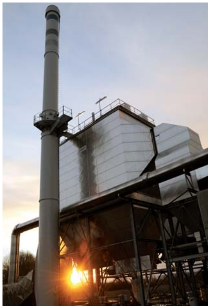
Biomasse-HKW in Augsburg (T. Hosemann /Stadtwerke Augsburg)
