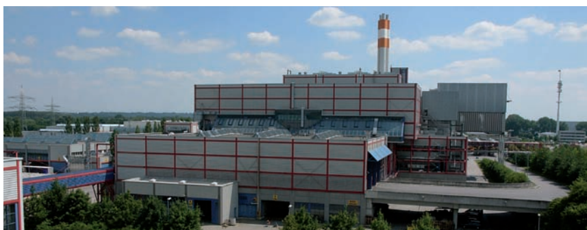
Abfallverwertung Augsburg GmbH in Augsburg-Lechhausen (AVA GmbH)
