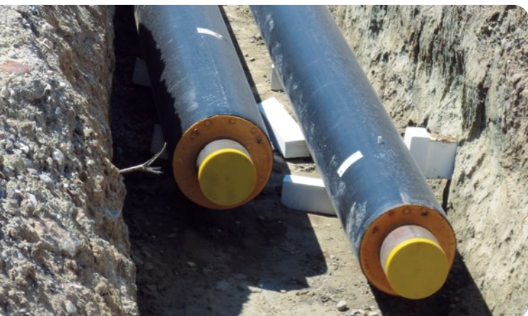
Fernwärmeführung in Weißenhorn 2018
