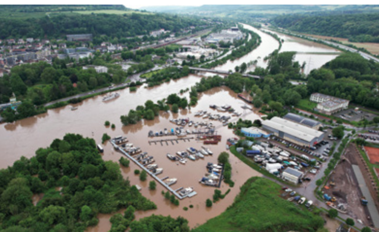
Hochwasser am 17.05.2024: die Saar überschwemmt die Kreisstadt Merzig.
